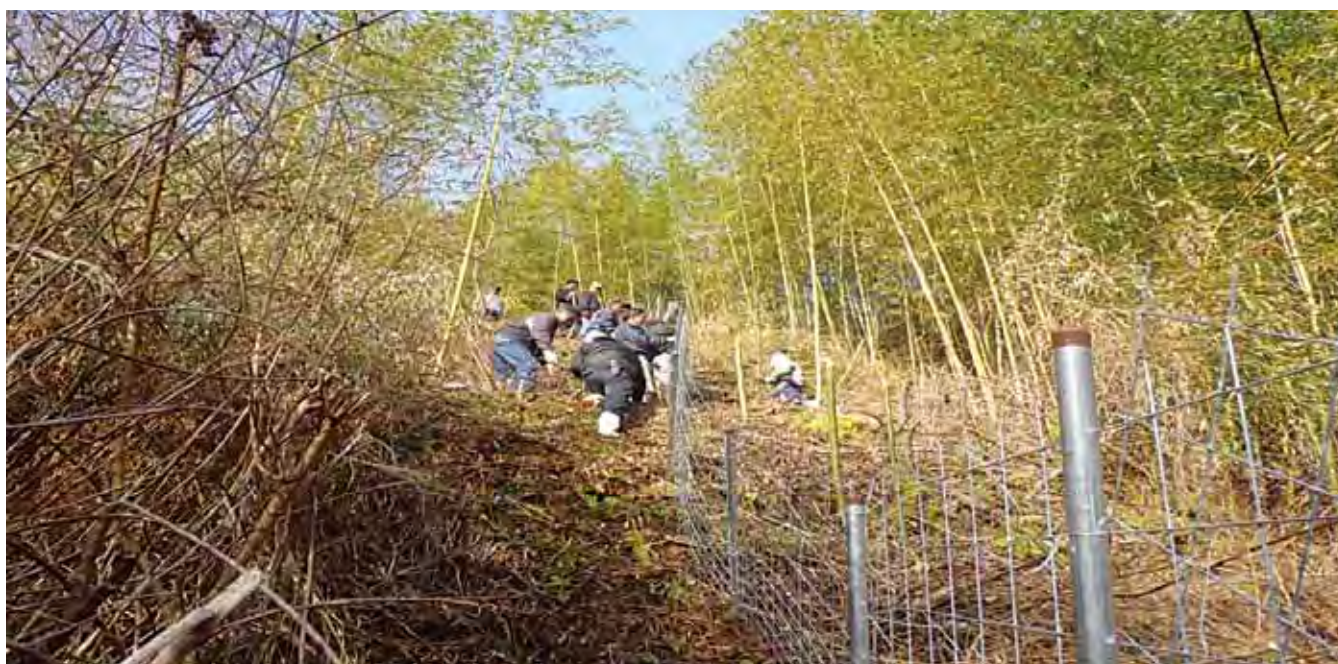
防護柵設置写真
